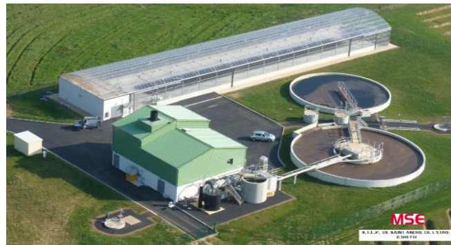
Vue aérienne de la station d'épuration
