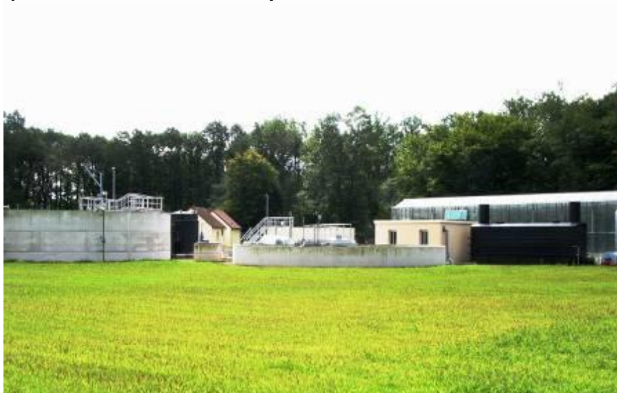
Vue d'ensemble de la station d'épuration
